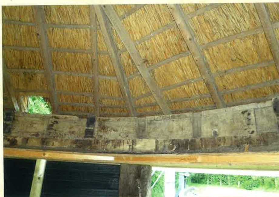
▲ Het oude puntdak heeft een nieuwe functie gekregen naast de molen. Inwendig is de oude keerkuip en de rollenvloer uit de molentijd nog goed herkenbaar (foto jsb, 1 juli 2014).
