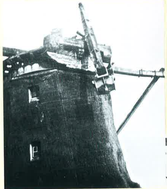
▲ De as wordt uit de molen gegooid.
