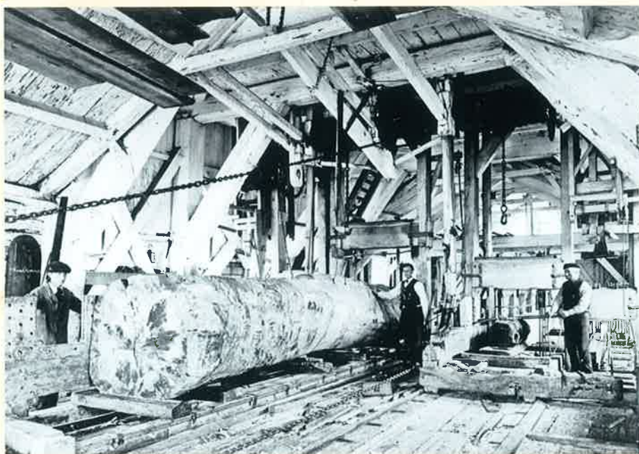
◀ Oude interieurfoto van d'Heesterboom die tevens een indruk geeft van hoe De Haan er vermoedelijk heeft uitgezien. De vier gebinten van het vierkant waarop het achtkant staat zijn herkenbaar. Boven de zaagramen de winderijen. In De Hoop in 't Zand doet een winderijrol dienst in het luiwerk (foto Regionaal Archief Leiden).
