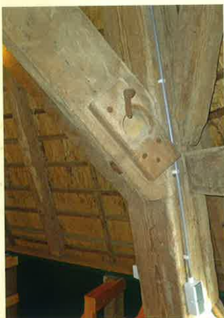
▲ Een lager met de pal voor de windas op de baliezolder om de steen mee open te leggen (foto jsb, 1 juli 2014).
