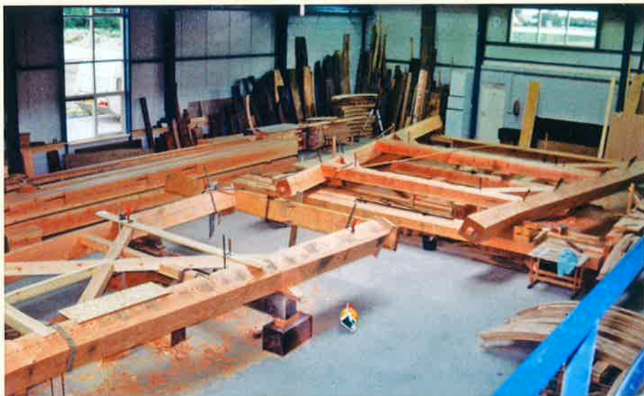
▲Het achtkant voor De Ster in Utrecht in de maak bij molenmaker Poland in Broek op Langedijk. Het achtkant heeft als gebruikelijk bij zaagmolens twee bindlagen; het bovenste voor de kapzolder, het onderste draagt de krukas (foto jsb, 24 mei 1997).
